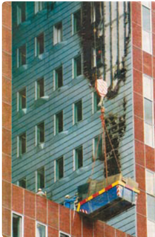
Kvalita materiálu je dôležitá. Pokým strešný konštruktér na to neupozorní, používa sa lacnejší materiál. Výsledok: drevená spodná stavba bola zasiahnutá požiarom.
